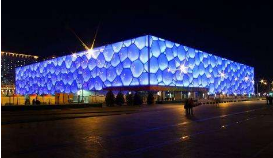
Figura 11: Instalação das provas de natação, “Cubo de Água”
